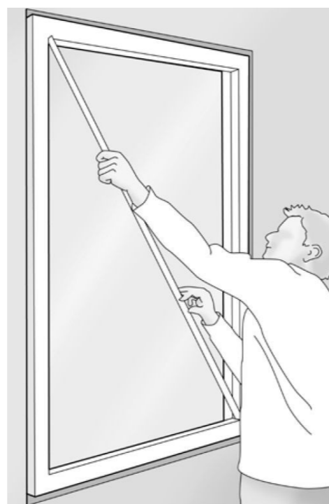
Fig 19. Diagonalmål skal være like, det indikerer riktig montering.
