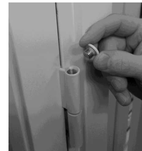
Fig 21. Demontering av dekklokk på toppen av hengsler.
